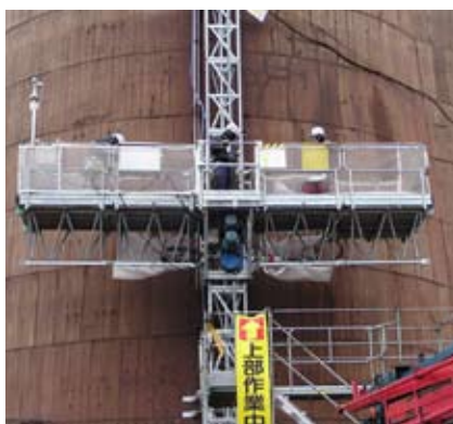
Podest elewacyjny PW-18 w czasie pracy
