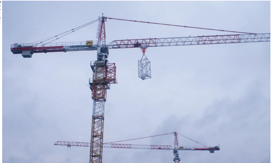
Żurawie Liebherr 280EC-H 12 Litronic, serwisowane przez firmę Lambor, na budowie realizowanej przez Alpine Construction Polska w sąsiedztwie Lotniska Chopina w Warszawie
