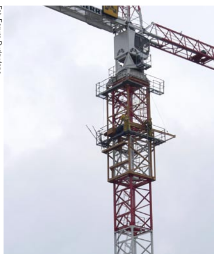
Operacja podwyższania została przeprowadzona metoda tzw. klatkowania
