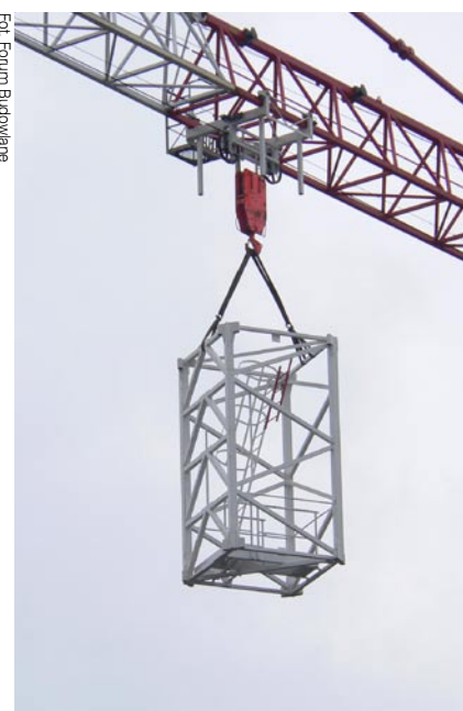
Transport kolejnego elementu wieży
